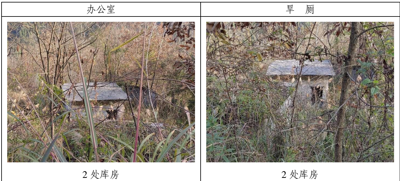
图2-9 矿山现有设施情况图
